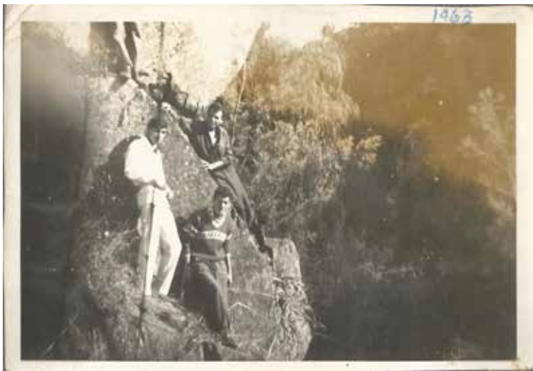
Sector "Alcantarilla Alta" (Puente del 1900 o Acueducto de Peñuelas). Febrero de 1963. Eduardo Valenzuela, Manuel Rubilar y Atilio Valdés.
