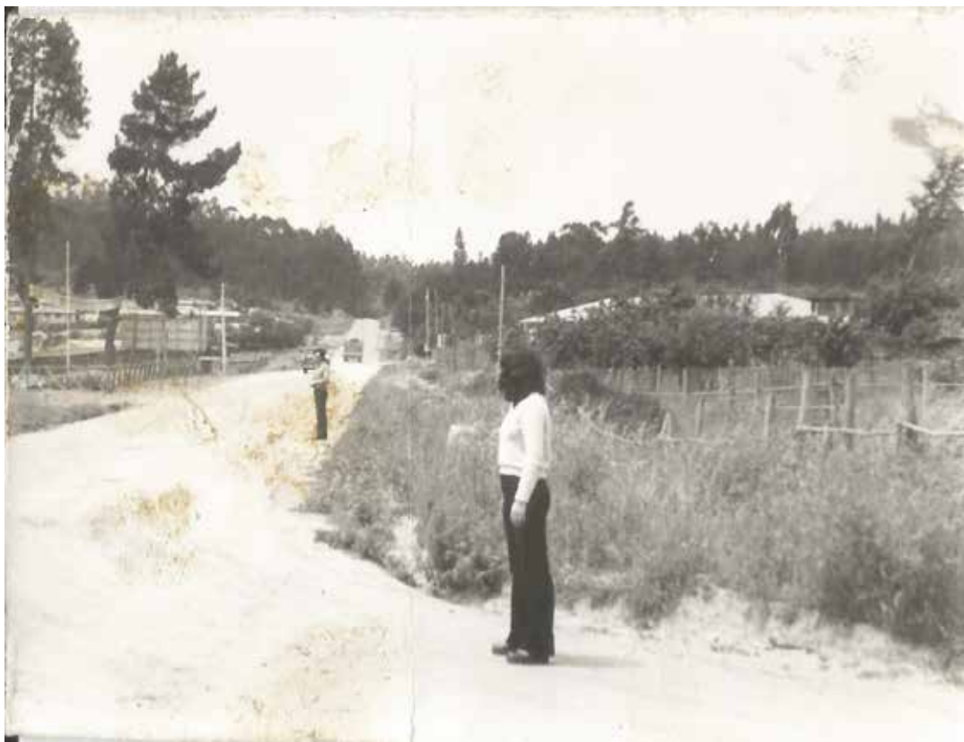
Antigua Variante a Viña (hoy Obispo Valdés Subercaseaux) con calle Central, altura de actual Plaza Lago Peñuelas. Años 70.
