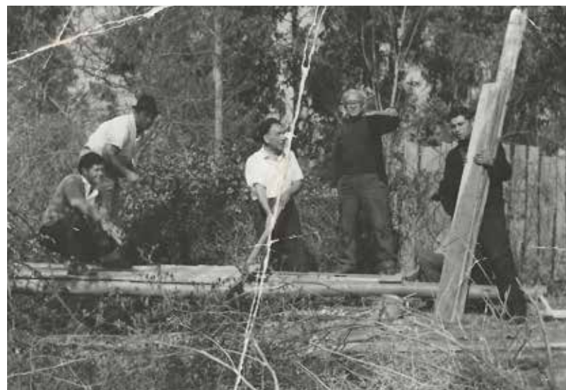
Reparación del puente sobre el estero Placilla, en calle El Sauce entre Virginia Bravo Letelier y Violeta Seitz por acción de la Junta de Vecinos del sector. Aparecen en la foto: Eusebio Rojas, Rubén Abarca, Arturo Naranjo y Juan Sepúlveda y Jorge Donoso. Sin fecha.
