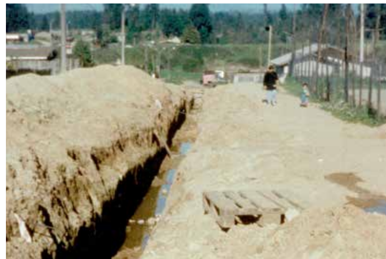
Calle Undécima, sector Aguas Buenas, en Placilla de Peñuelas. Años 90. Trabajos de instalación de agua potable.
