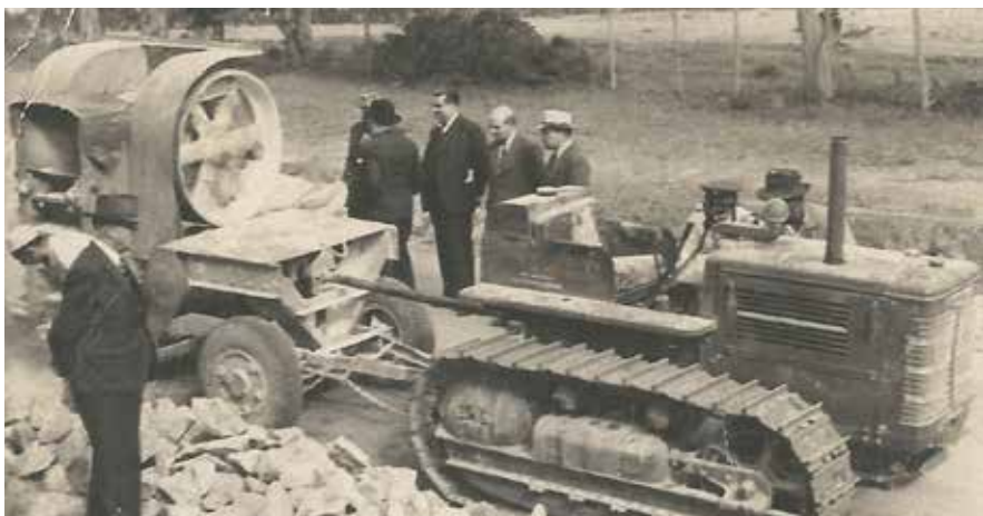
Inspección de la maquinaria de Vialidad. 1948. Tractor y chancadora que triturbaba las piedras para hacer caminos en Chile. En el extremo derecho aparece el maquinista Rolando Núñez González.
