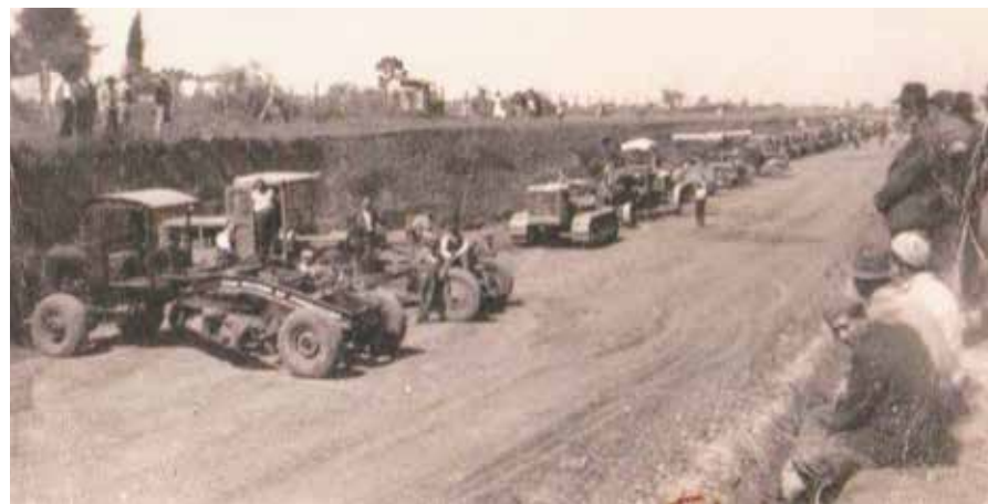
Construcción Ruta 68. 1956. Maquinaria de Vialidad en construcción de caminos. Destaca en Placilla de Peñuelas el aporte de don Rolando Núñez González, maquinista que trabajó en la pavimentación del antiguo Camino Real.
